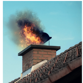
Kaminbrand durch Glanzruß- Ablagerungen
