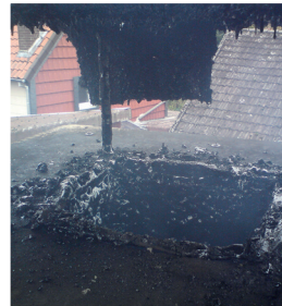
Stark verteerte Schornsteinmündung
