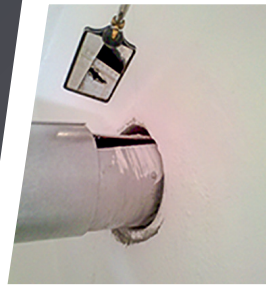
Defektes Abgasrohr
