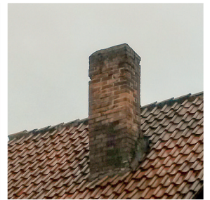
Schadhafter Schornsteinkopf
