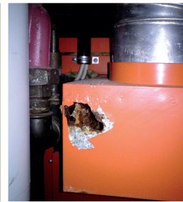
Defekte Strömungssicherung
